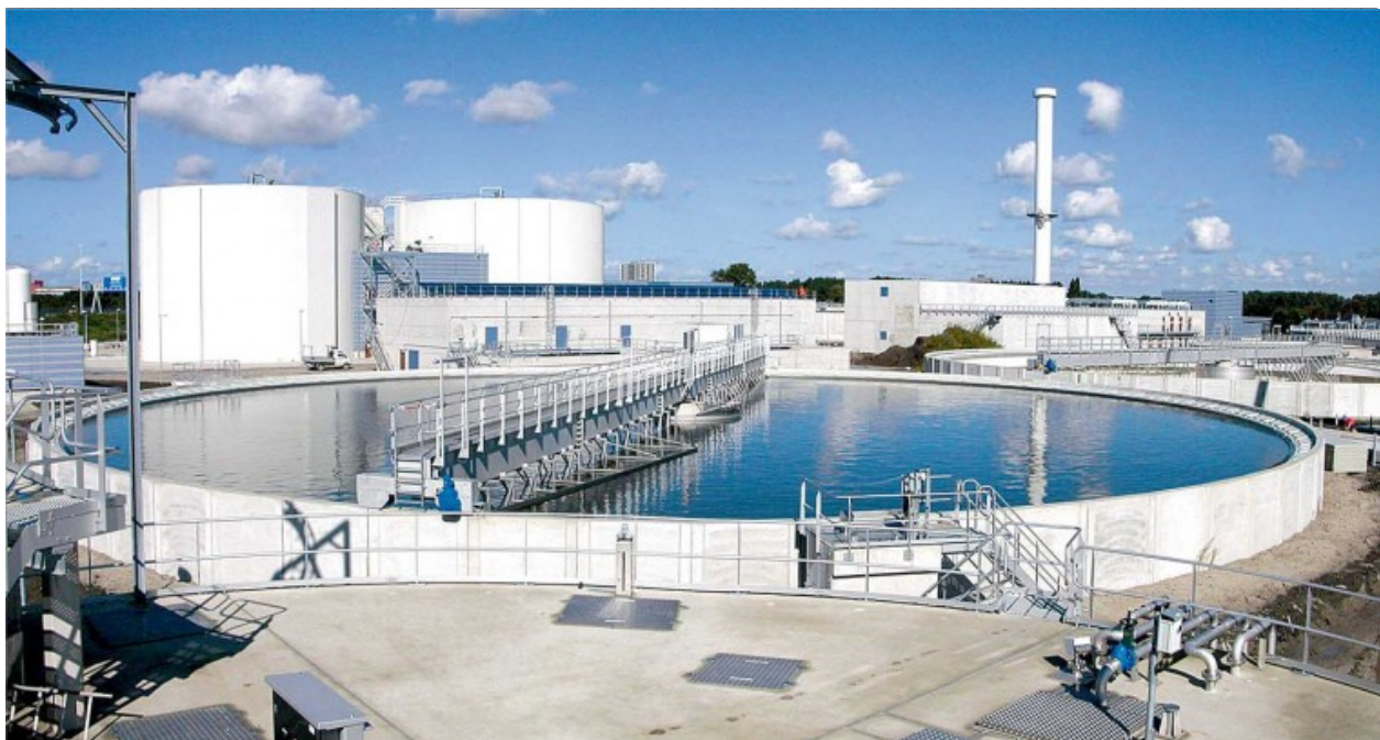
Водоочистные сооружения (Фото: http://vseon.com/analitika/programmy/programma-chistaya-voda-2 )
